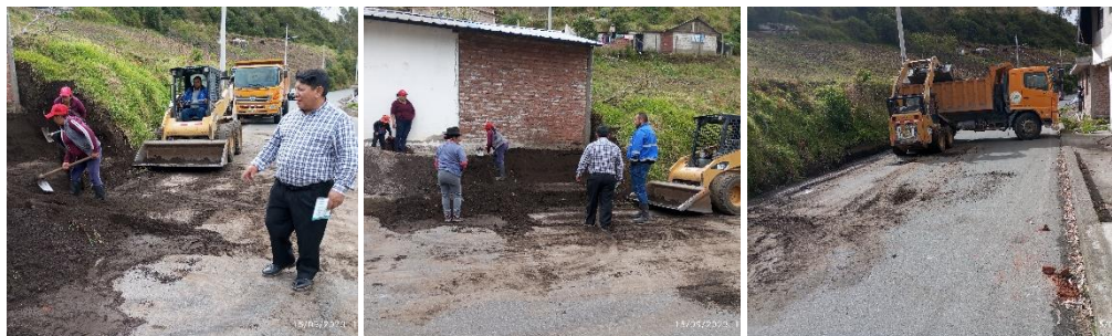
Ilustración 10. MANTENIMIENTO VIAL LA LIBERTAD
