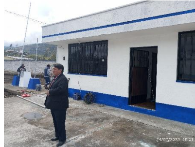
Ilustración 13. UPC-PINTURA, INSTALACIONES DE AGUA POTABLE Y ELECTRICAS
